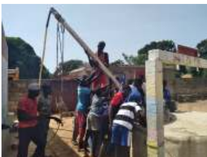
Plaatsing pompbuis in boorgat met hulp van leerlingen
