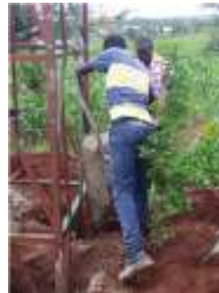
Storten van beton voor veilige inbouw pomp
